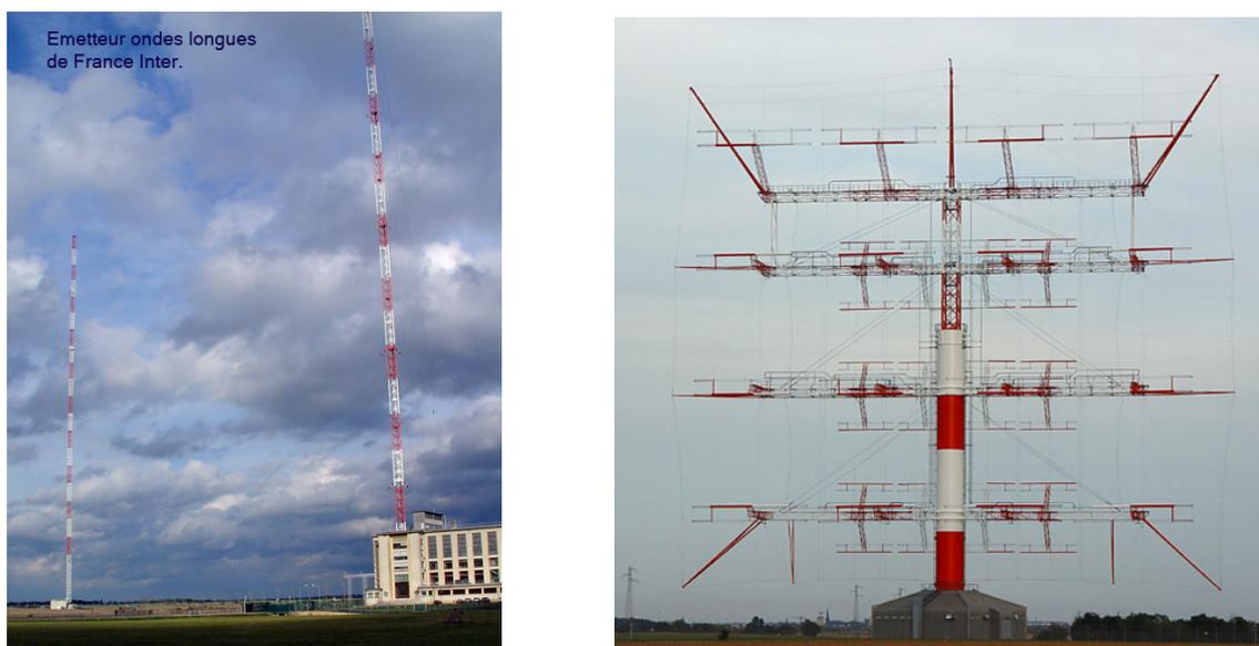
FIGURE 59 – *Gauche* : l’ancien émetteur de France Inter en ondes longues sur 162 kHz implanté à Allouis, constitué de deux pylônes de 350 m. *Droite* : antennes des émetteurs ondes courtes de 500 kW de Radio France International (RFI) à Ste Austrille près de Issoudun.
