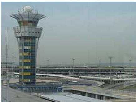
Le radar émet des suites d'impulsions d'ondes électromagnétiques représentant des messages d'interrogation. Les transpondeurs à bord des avions détectent ces interrogations, les décodent, et émettent à leur tour des suites d'impulsions d'ondes électromagnétiques représentant les réponses à chaque interrogation reçue. Les réponses des avions permettent de définir leur position.
